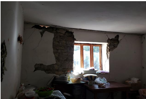
Fig.15. Çarje në murature guri të pakontraventuar horizontalisht. Ndërtesë 1KT muraturë guri dhe tulle. Fshati Ndroq
