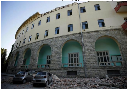
Fig.20. Shkëputje paneli murature mbajtëse, çarje vertikale në muraturë. Godinë 5K me muraturë tulle silicate, Lagjja Kombinat, Tiranë.
